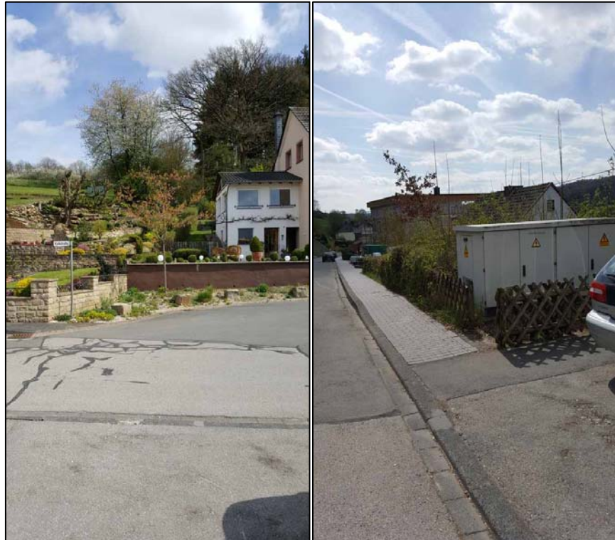
Bebauung unterhalb Einlauf, Trafostation
