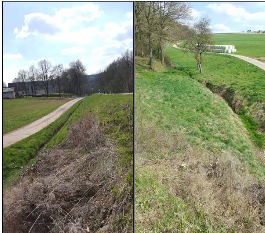
vertiefte Gräben im Bereich des Durchlasses LBM
