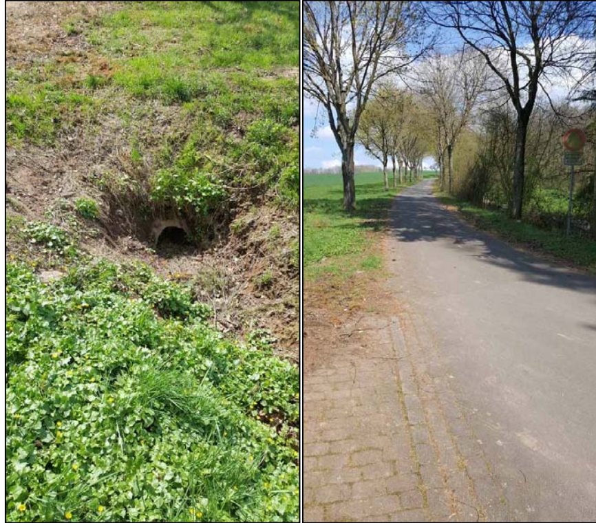
Einlauf Ende Kapellenstraße, Bankette WiWeg
