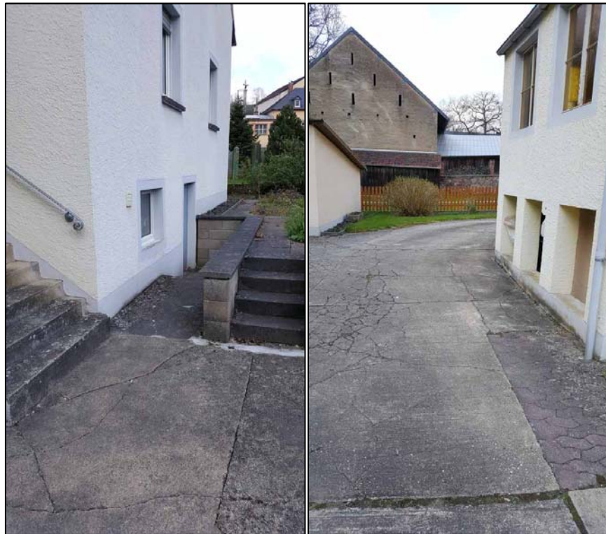
Mühlenstraße 1, rückwärtiger Bereich
