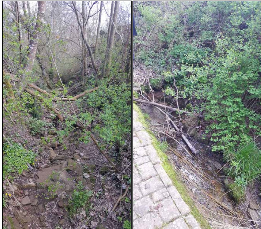
Totholz und beginnende Erosionsschäden
